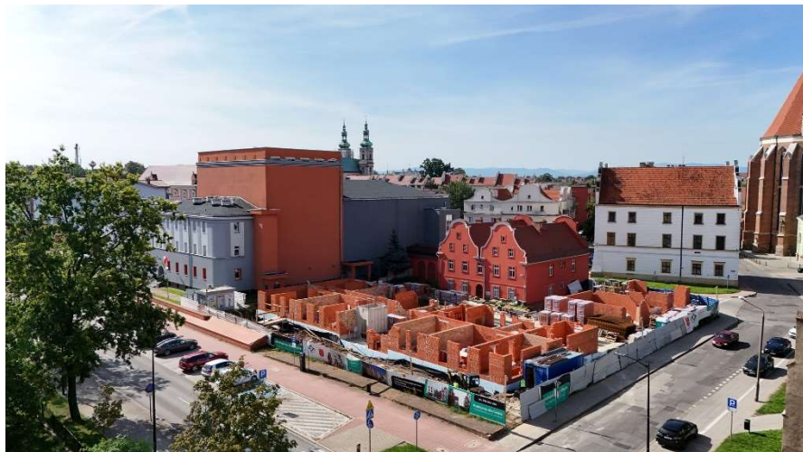
Źródło: Urząd Miejski w Nysie, budowa mieszkań przy ul. Wałowej w Nysie
